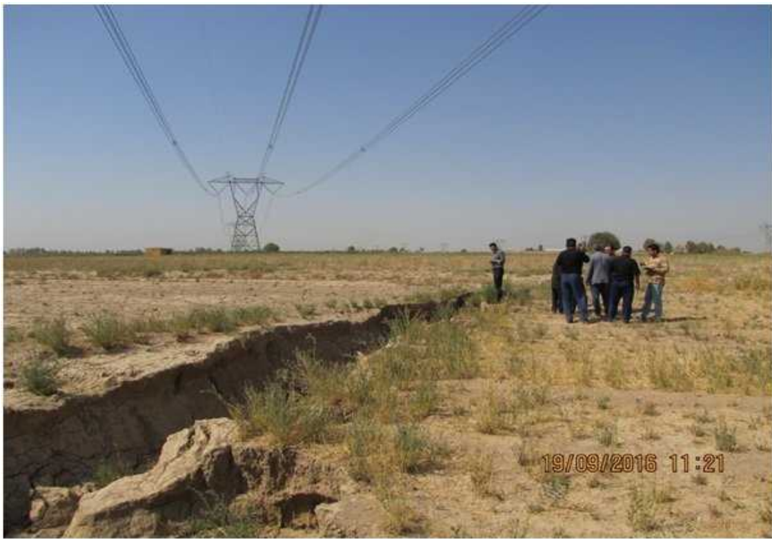
Subsidence in tehran テヘランの地盤沈下
