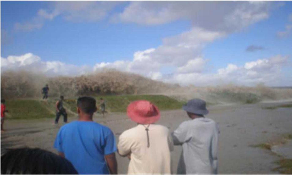
Overtopping of the sea defence 2008 waves were as high as 10 meters. 2008年の海上波の越波は10メートルにも達した。
