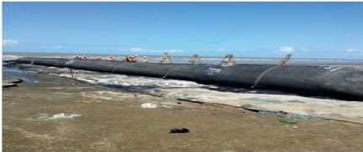
GROIN USING GEO-TUBE ジオチューブを使用した復旧
