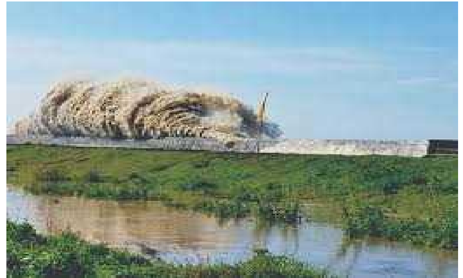
Overtopping of the sea defence 2008 waves were as high as 10 meters. 2008年の海上波の越波は10メートルにも達した。
