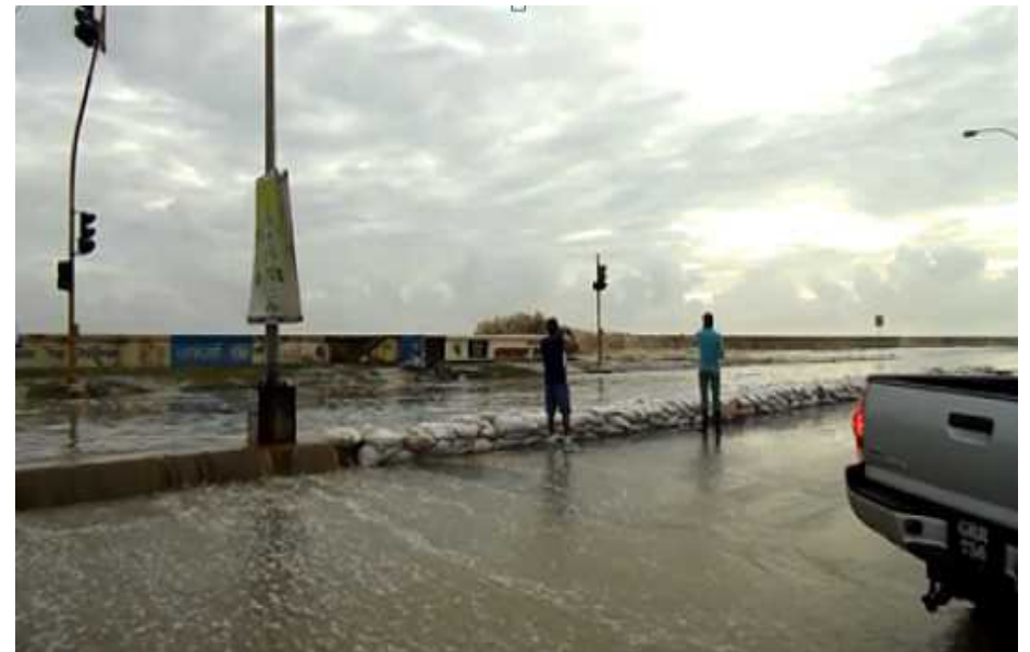
Overtopping of the sea defence 2008 waves were as high as 10 meters. 2008年の海上波の越波は10メートルにも達した。
