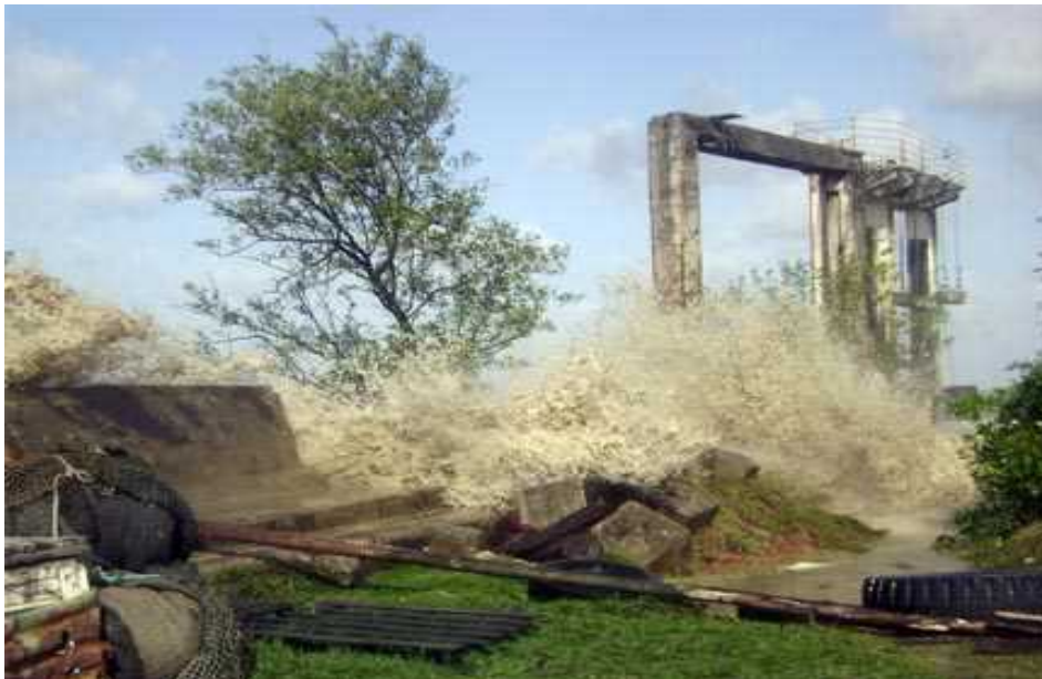
Overtopping of the sea defence 2008 waves were as high as 10 meters. 2008年の海上波の越波は10メートルにも達した。
