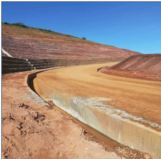
斜面崩壊後の斜面崩壊を防ぐための斜面切削 土壌盛土の特性(凝集力と内部摩擦角)
