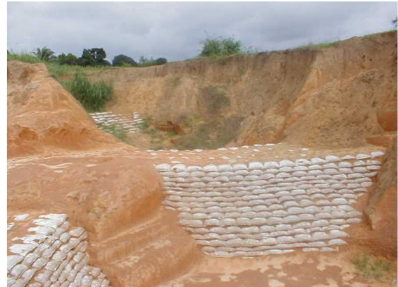
土のうを利用した防水層を構築する。
