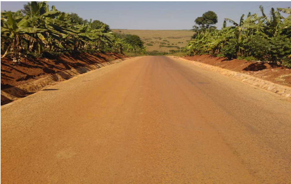
Paved Regional Roads 舗装された地方道路
